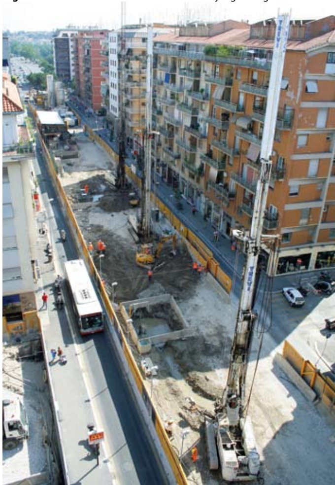
Figura 25 – Stazione Libia/Gondar – esecuzione jet-grouting
