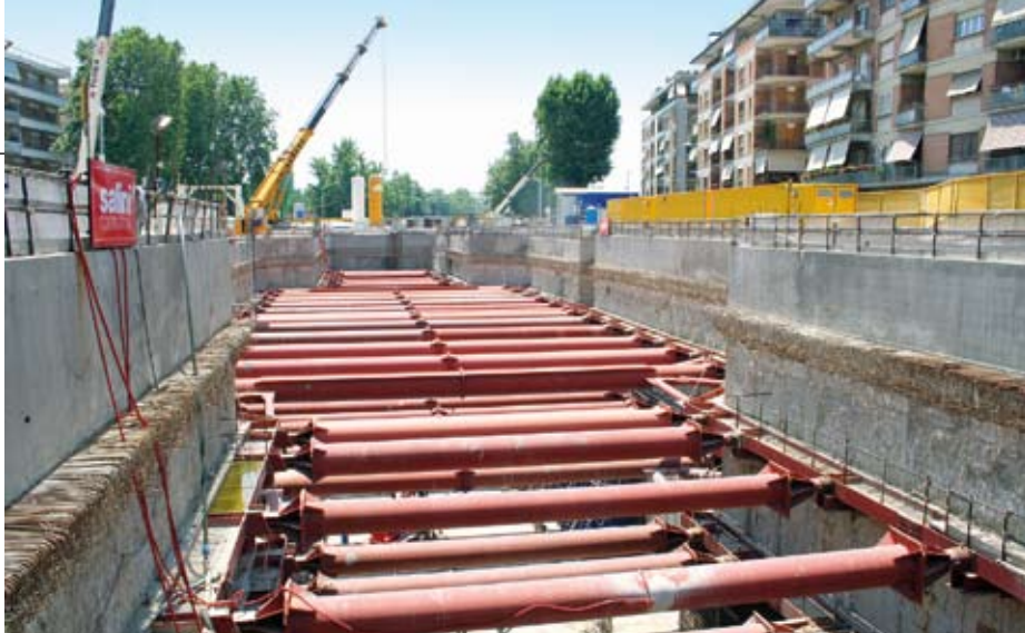
Figura 17 – Stazione Conca d'Oro – scavo in corso
