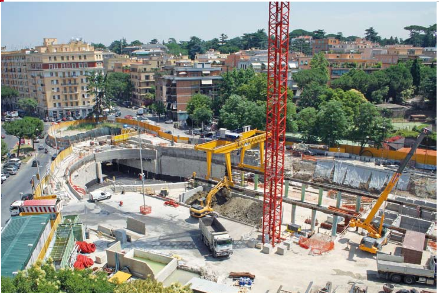
Figura 26 – Stazione Annibaliano – situazione generale cantiere
