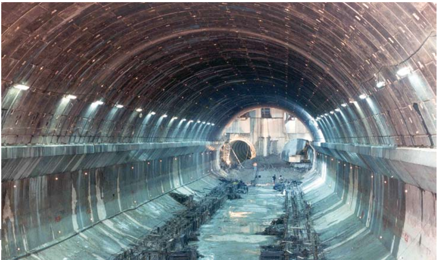
Figura 4 – Linea A – Stazione Baldo degli Ubaldi – volta attiva (Lunardi, 2000)
