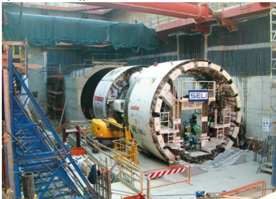
Figura 19 – TBM – assemblaggio a fondo scavo
