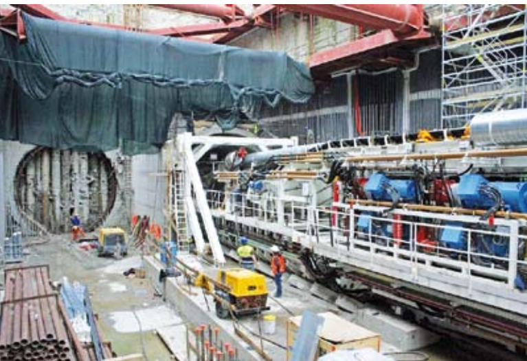
Figura 21 - TBM - partenza con lo scavo della galleria binario pari
