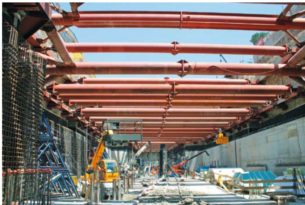
Figura 18 – Stazione Conca d'Oro – scavo ultimato
