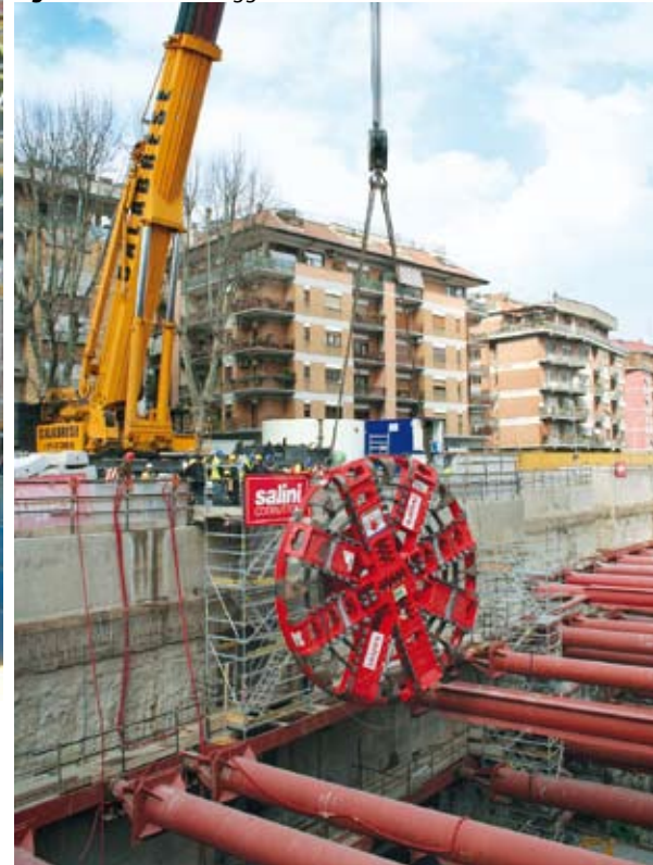
Figura 20 – TBM – calaggio a fondo scavo della testa fresante
