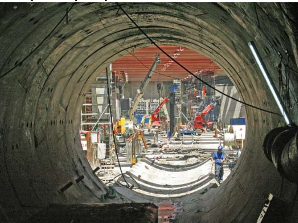
Figura 23 - TBM - galleria eseguita
