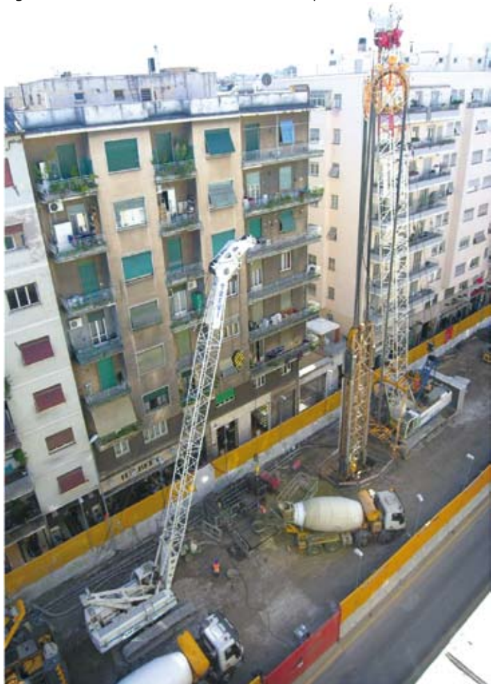
Figura 24 – Stazione Libia/Gondar – realizzazione paratie con idrofresa
