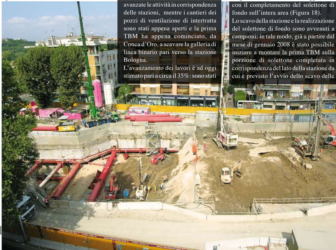
Figura 16 – Stazione Conca d'Oro – avvio dello scavo
